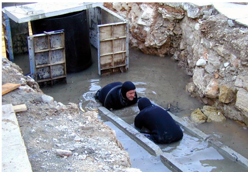
Polaganje kanalizacijskih cijevi uz pomoć ronilaca
