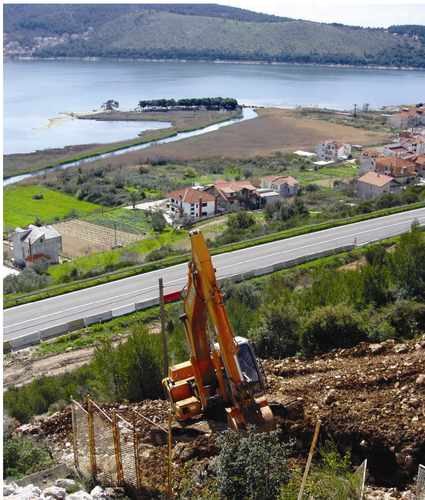
Gradnja vodoopskrbnog cjevovoda za Trogir
